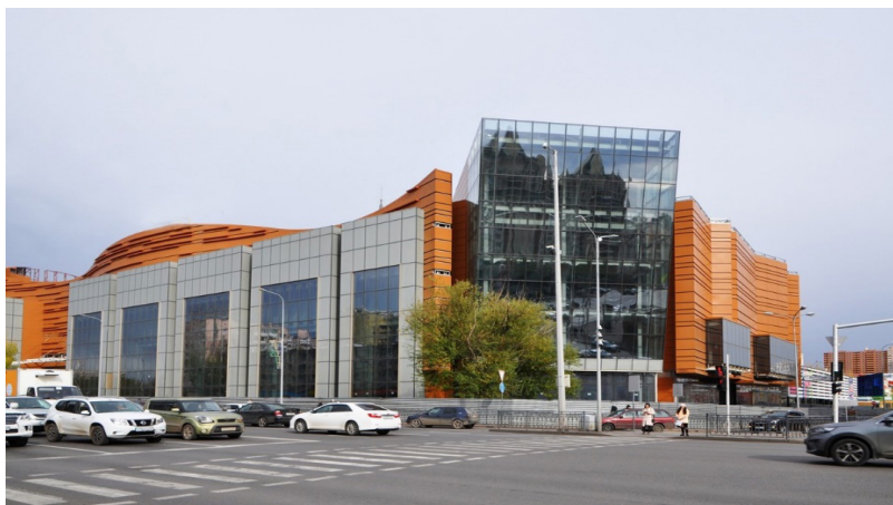
Рисунок 7. Общий вид фасада торгово-развлекательного центра Сити Палас в г.Астане
