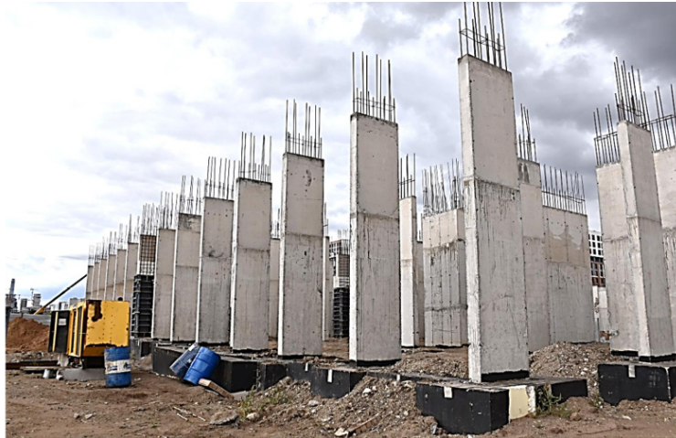
Рисунок 4. Общий вид строительных конструкций (пилоны, диафрагмы жесткости) на участке многоквартирного жилого комплекса Кок-Тобе, г.Астана
