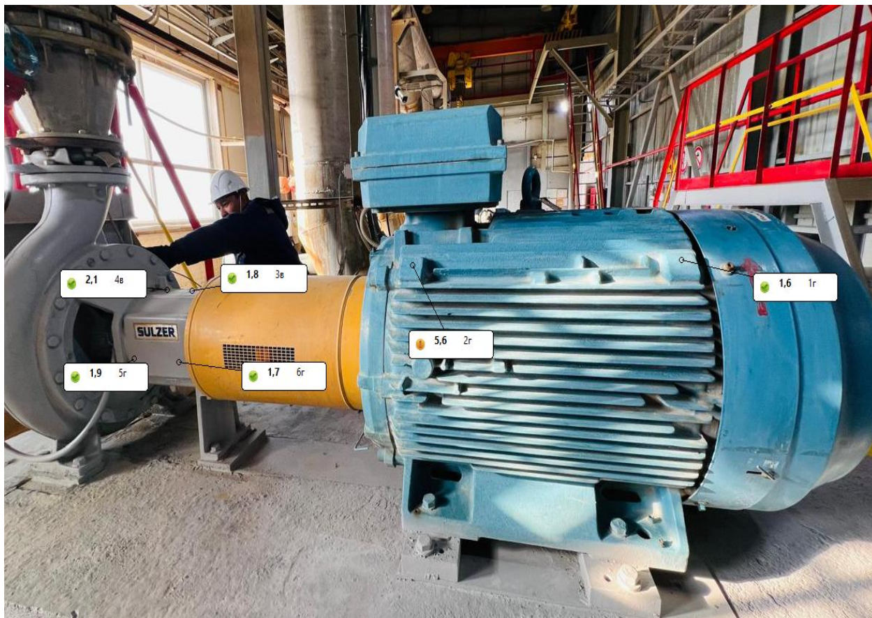
1-сурет. Орталықтан тепкіш сорғы қондырғысының жалпы көрінісі
