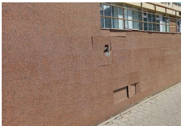
Слив воды, выходящий на тротуар
