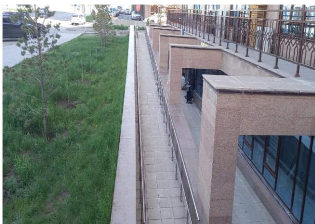
Здание ниже дороги
