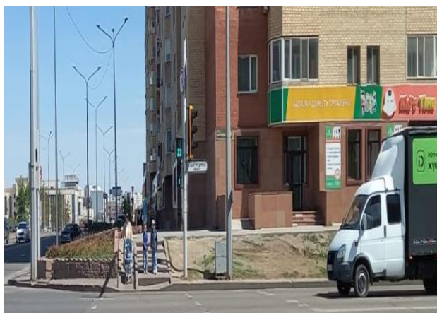
Здание выше отметки дороги
