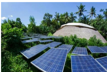
Рисунок 6. Фотоэлектрическая система со 118-тью солнечными панелями в школьном комплексе Bali Green School
