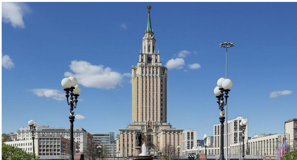
Рисунок 1. Гостиница «Ленинградская» – отель «Хилтон», ул. Каланчёвская, г. Москва.
