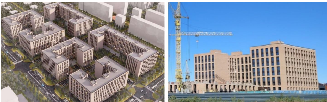
Рисунок 3. Жилой дом по улице Караменде би Шакаулы в г. Астане.
