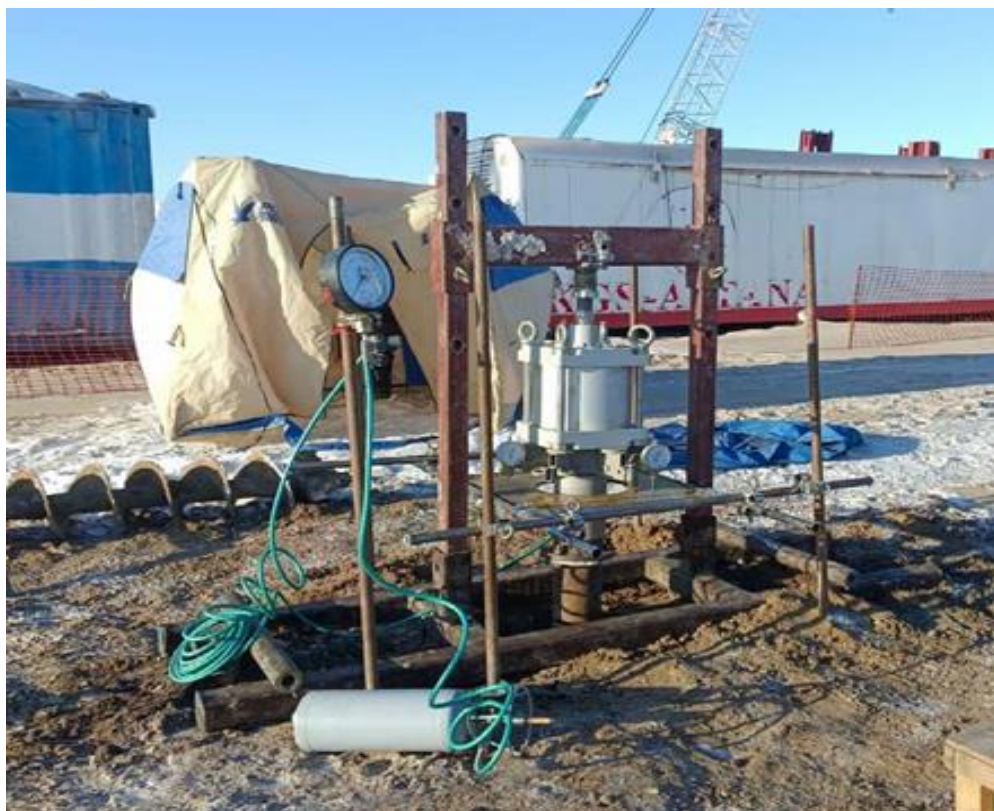
Рисунок 1. Проведение испытаний грунта штампами на площадке
